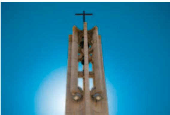
Torre Iglesia, Fayón
