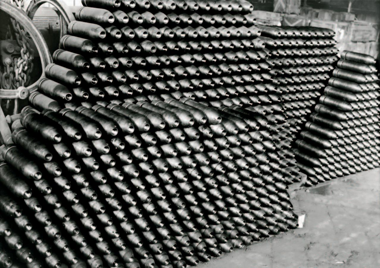
28 | *Pilas de proyectiles del calibre 7,5 sin la banda de forzamiento ni espoletas*
