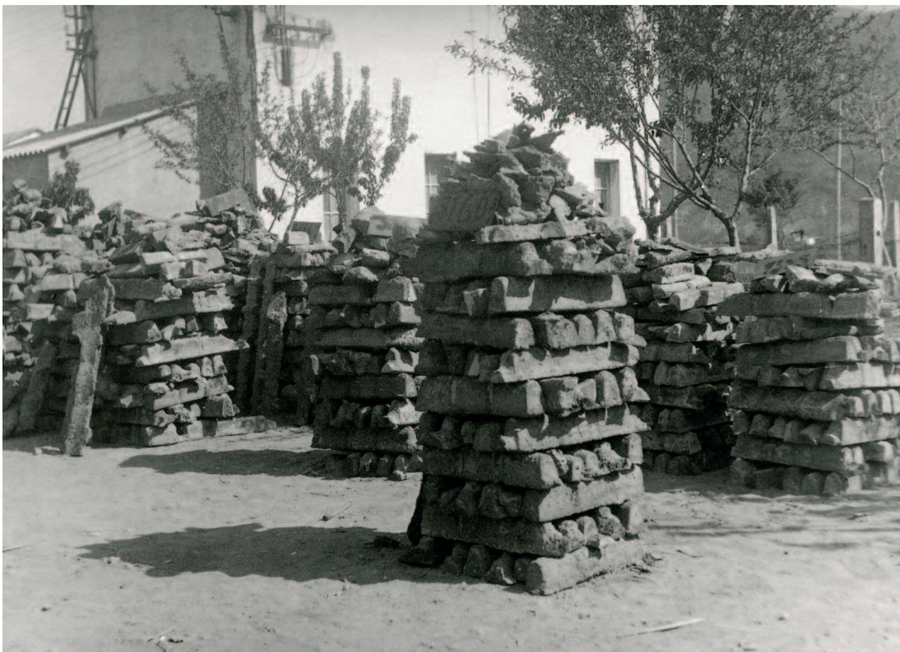
*Lingotes apilados para la fabricación del acero de los proyectiles* | 5
