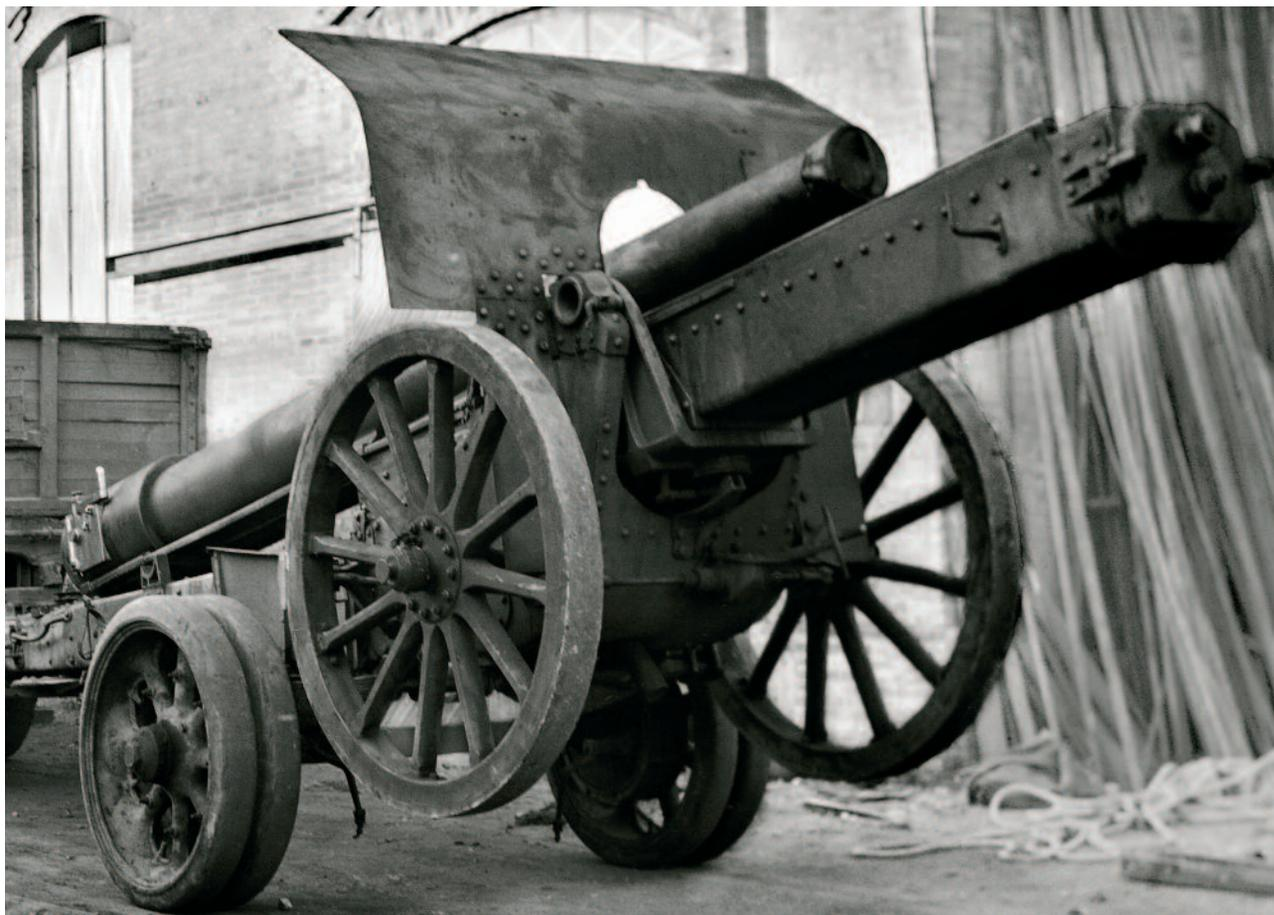
18. Cañón de acero de 149,1/27, tiro rápido Krupp modelo 1913 sobre un carrillo de transporte enganchado a un camión en el patio de Talleres Mercier. El tubo está sacado de batería, esto es, se ha deformado su posición normal para disparo con el objeto de que los pesos en ruta se estabilicen. h. 1936-1937. Archivo Talleres Mercier.
