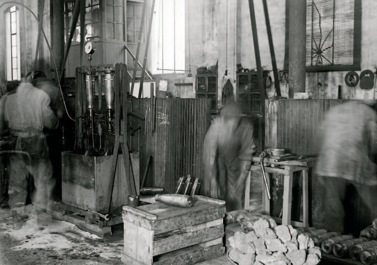
10 | *Pruebas de precisión hidráulica de los proyectiles*
