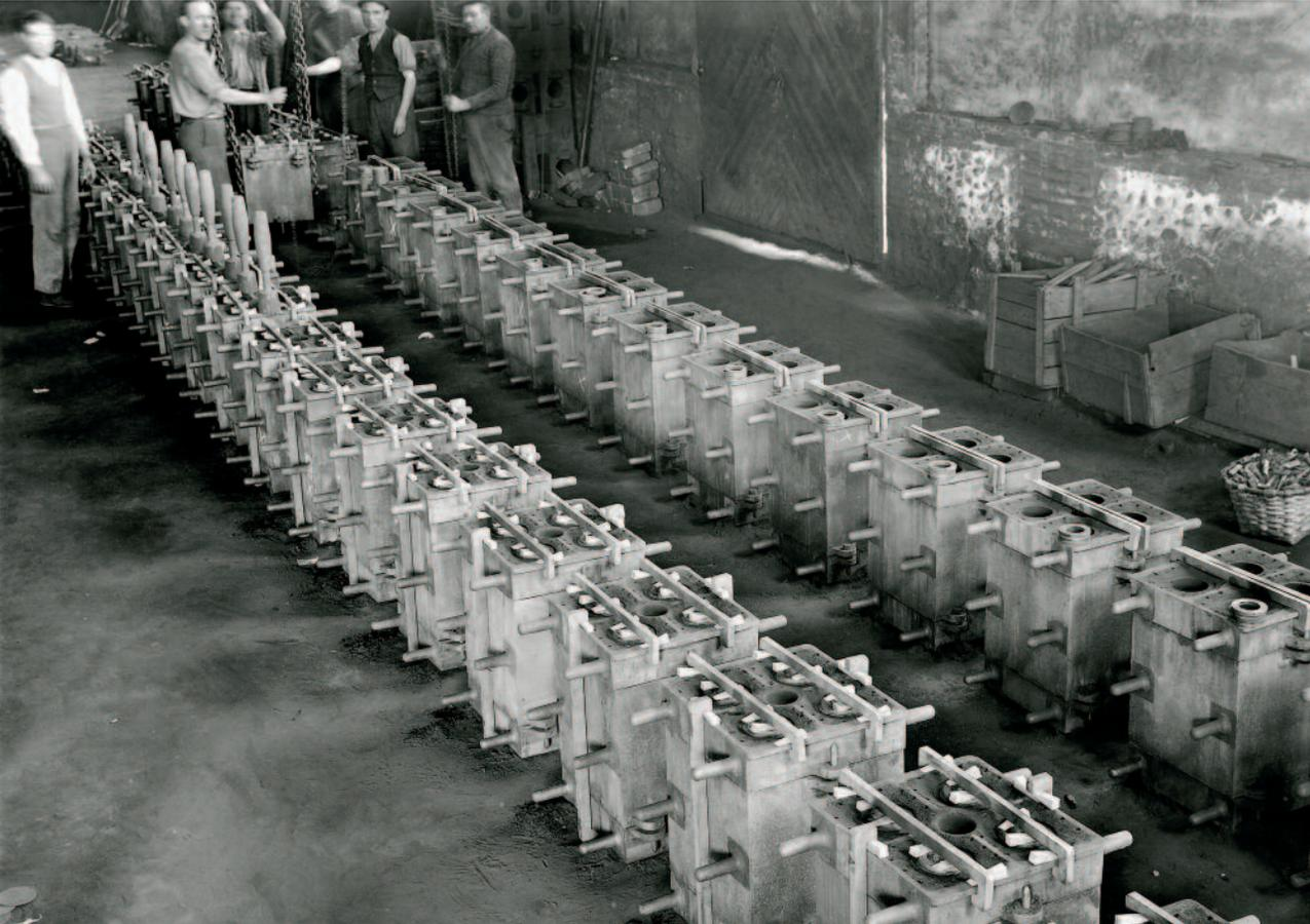
8 | *Fundición de granadas rompedoras del calibre 10,5 cm*
