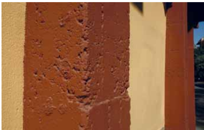
86. Detalles arquitectónicos del pórtico sobre el empleo del hormigón armado en la construcción de la plaza de Zaragoza. 1. Techo del pórtico. 2. Pilares contrafuerte. 3. Pilares, jácenas, zunchos y techo. 4. Losas de piedra y ladrillo que forran los pilares exteriores de hormigón hacia la fachada. 5 y 6. Detalles del hormigón de los pilares contrafuerte que han sido poco picados después del vertido.
