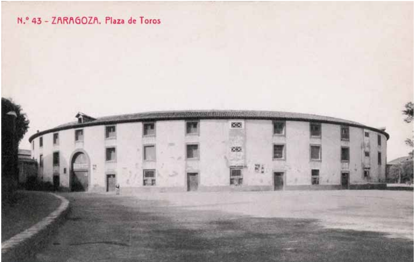
47. Fototipia Thomas, 43. Zaragoza. Plaza de Toros, h. 1910-1916, tarjeta postal, fototipia sobre cartulina, Colección Pérez Latorre, Zaragoza. Fachada del coso hacia la calle Pignatelli poco antes de la gran reforma de 1916-1918; a la izquierda, la tapia del jardín de la Casa de Misericordia y la Puerta Principal de la plaza, convertida en Puerta Grande en la reforma de 1916-1918. La configuración de la fachada del coso taurino seguía siendo la original de 1764-1765, salvo por pequeñas modificaciones introducidas en 1884 (sustitución del alero originario) y entre finales del siglo XIX y principios del XX (perfilado general de vanos y modificación de algunos de ellos).
