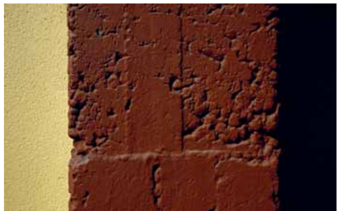
86. Detalles arquitectónicos del pórtico sobre el empleo del hormigón armado en la construcción de la plaza de Zaragoza. 1. Techo del pórtico. 2. Pilares contrafuerte. 3. Pilares, jácenas, zunchos y techo. 4. Losas de piedra y ladrillo que forran los pilares exteriores de hormigón hacia la fachada. 5 y 6. Detalles del hormigón de los pilares contrafuerte que han sido poco picados después del vertido.
