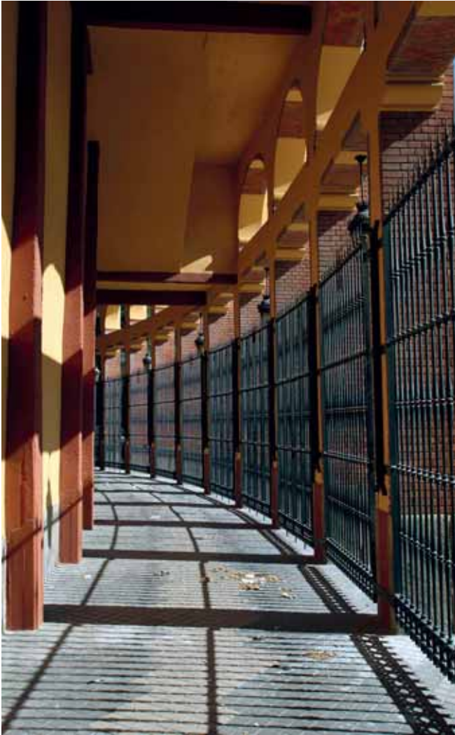
83. Galería exterior de la plaza de toros de Zaragoza. Pilares, jácenas, zunchado y techo son de hormigón armado; el ladrillo y la piedra forran los pilares y arcos de la fachada.
