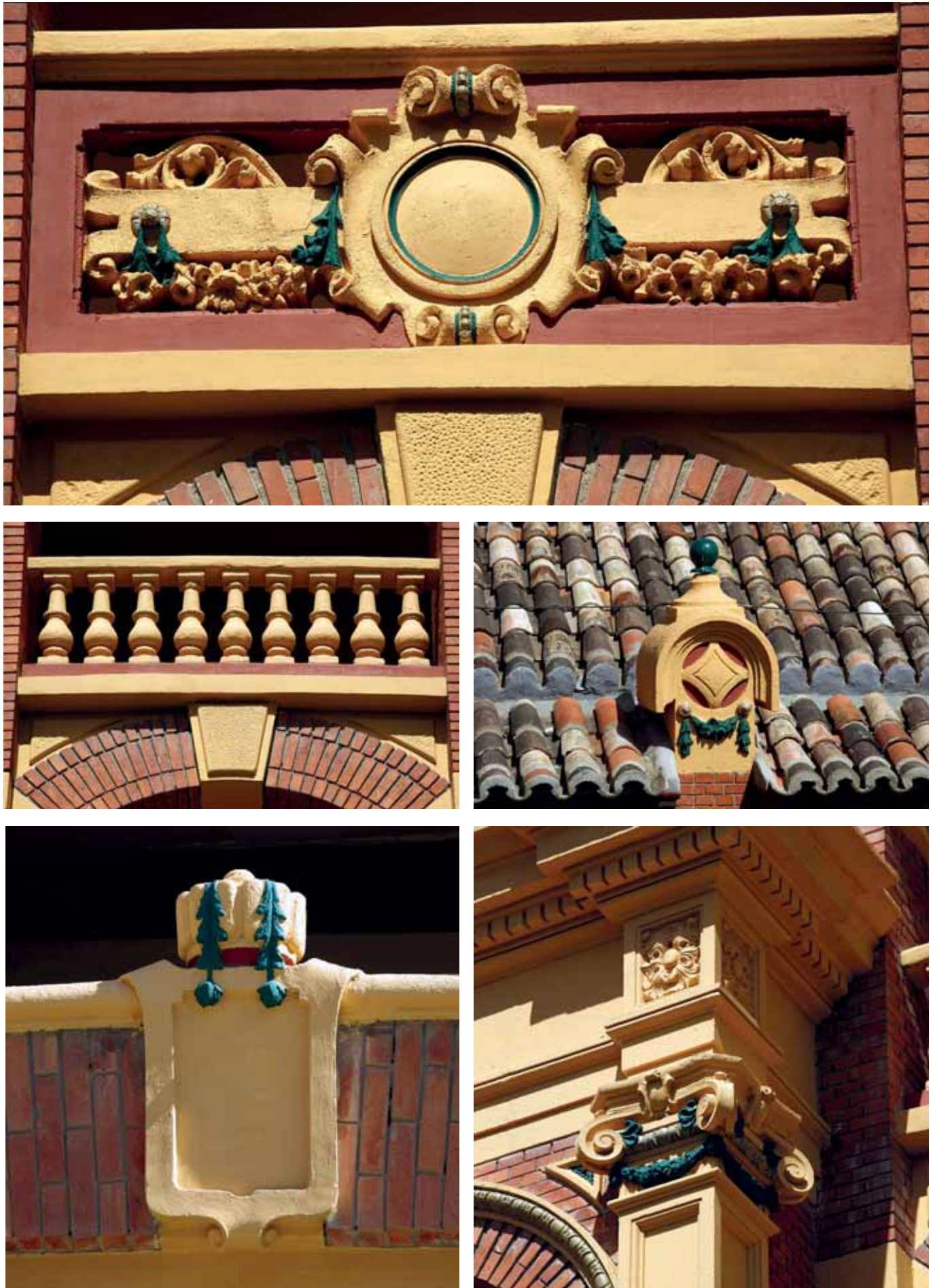
82. Detalles arquitectónicos de la fachada de la plaza de Zaragoza. 1. Antepecho del deambulatorio del piso primero. 2. Balastrada del deambulatorio del piso segundo. 3. Coronación de uno de los pilares del pórtico exterior. 4. Escusón coronado decorativo del centro del zuncho del pórtico. 5. Pilar, capitel y entablamento del segundo cuerpo del cubo derecho de la Puerta Grande.
