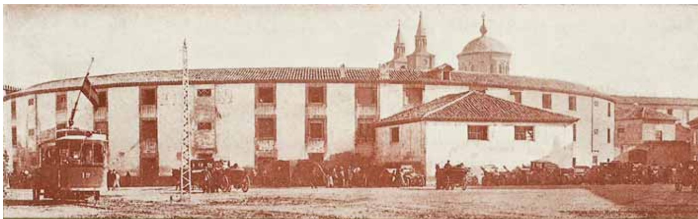
26. Fotografía anónima, Fachada O de la plaza de toros de Zaragoza , s. a. (antes de 1916), fotograbado sobre papel couché , colección particular. A la izquierda, el tranvía urbano que recorría la calle Ramón Pignatelli y que motivó el vuelo en hormigón armado de la ampliación de la plaza realizada por los arquitectos Navarro y Martínez de Ubago (1916-1918).
