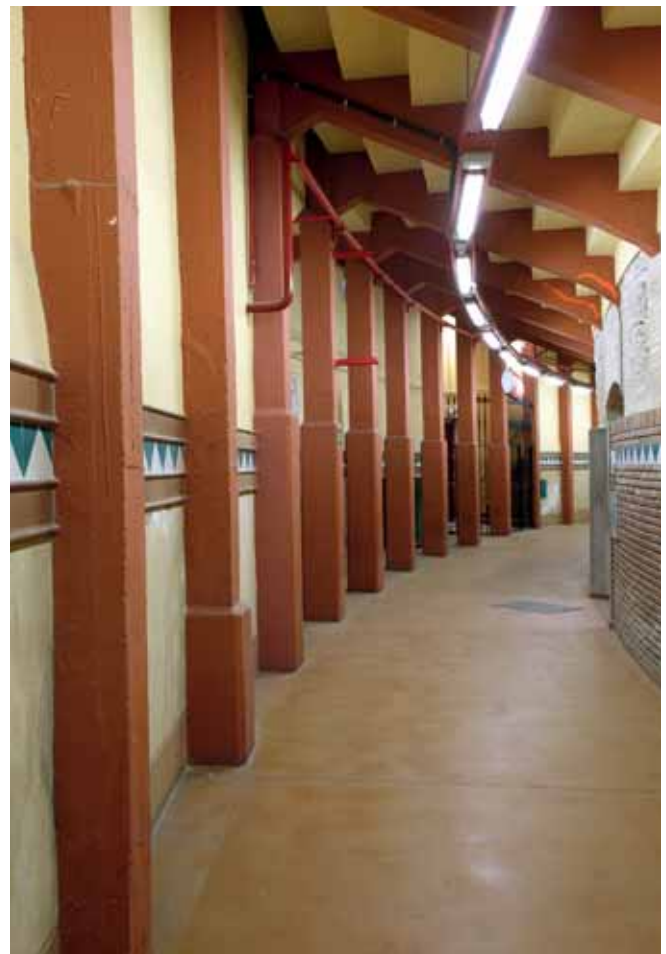
102. Deambulatorio de la planta baja, detalle de los pilares y forjado de los tendidos de hormigón armado.
